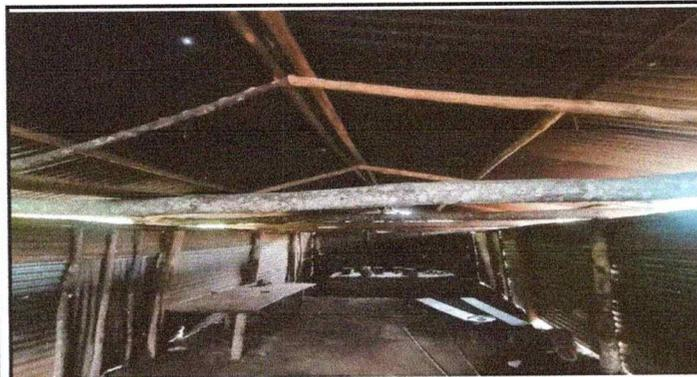
Foto 3: Se observa la necesidad de cambiar las costaneras de la cocina para mejorar el entechado
