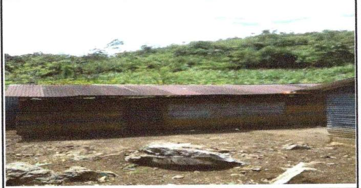
Foto 2: Se observa la necesidad que tiene la cocina de la escuela, como el cambio total de las láminas.
