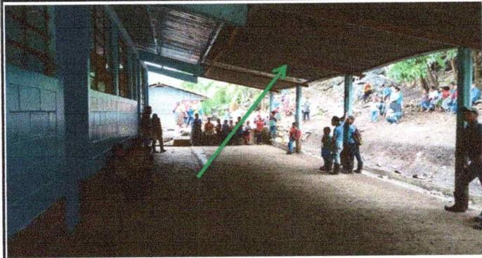
Foto 1: Se observa la necesidad de cambiar las costaneras y laminas del corredor de la escuela
